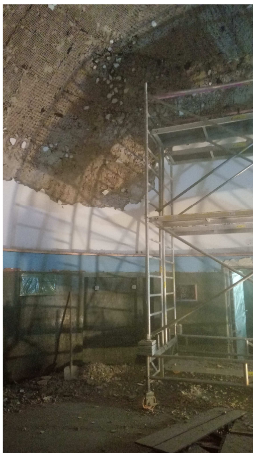
Rekonstrukce sálu planetária
