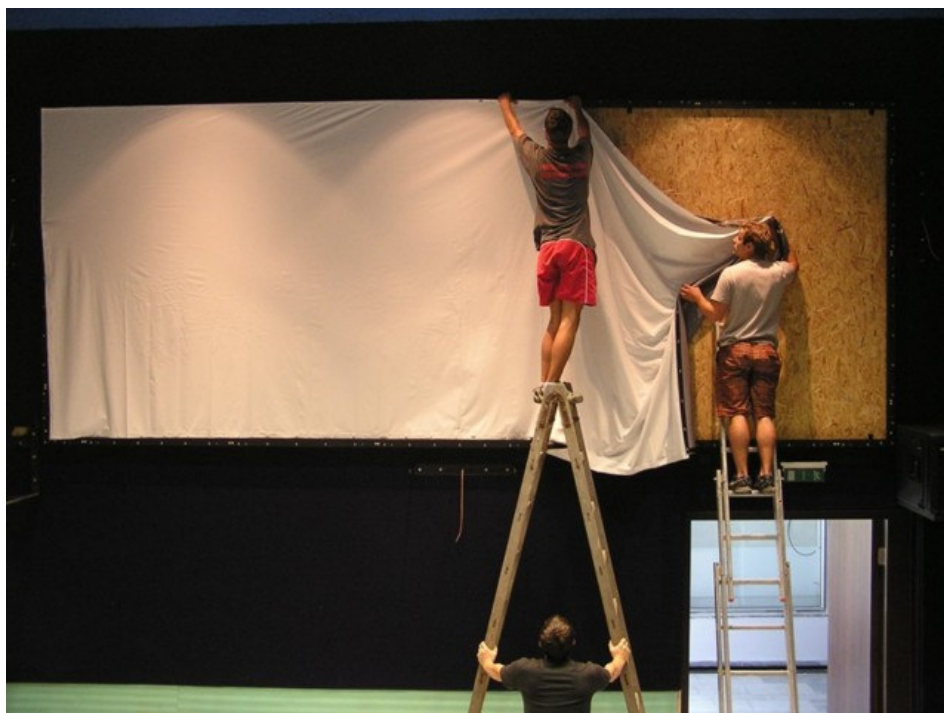
Rekonstrukce kinosálu finišuje
