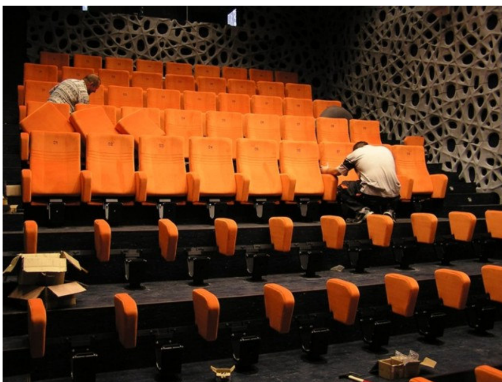
Rekonstrukce kinosálu finišuje
