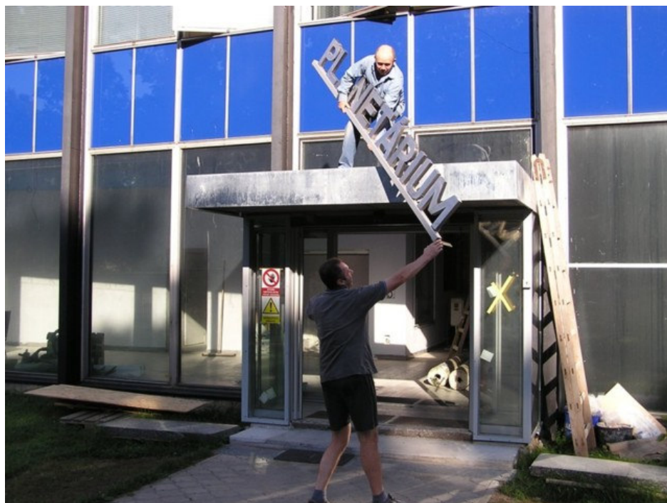
Rekonstrukce vstupu do budovy
