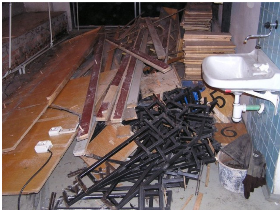
Zahájení rekonstrukce kinosálu
