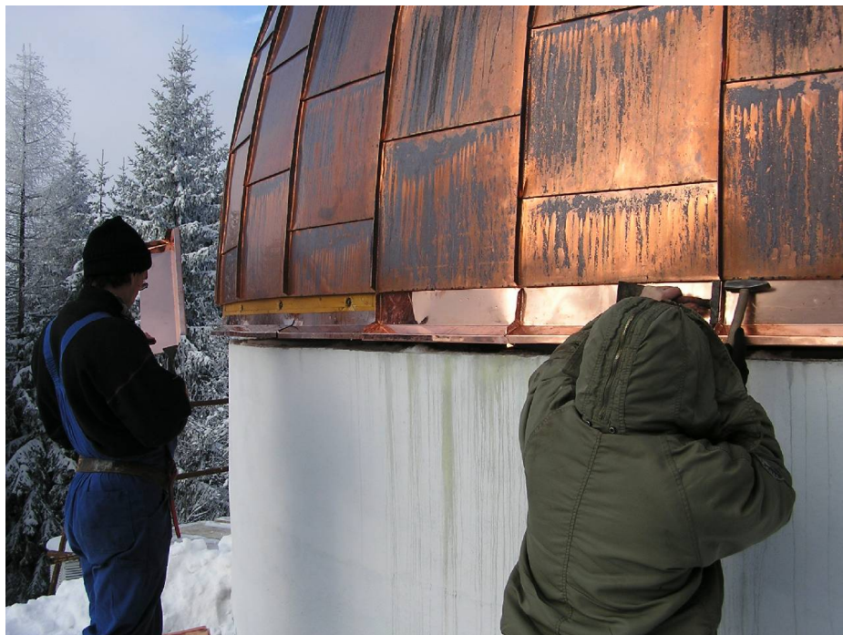
dokončovací práce (listopad-prosinec 2005)
