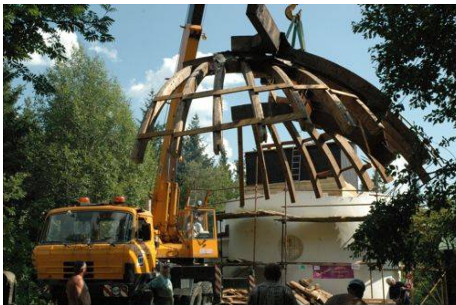
demontáž staré kopule teleskopu KLENOT (červenec 2005)
